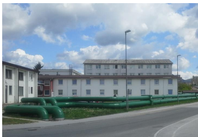
Slika 17: Magistralni vročevod TEŠ - CEP po obnovi (pristop k zmanjšanju toplotnih izgub)
