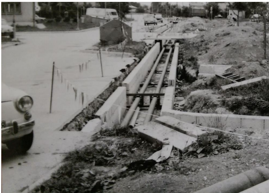
Slika 7: Gradnja distribucijskega omrežja v Šoštanju (1979)
