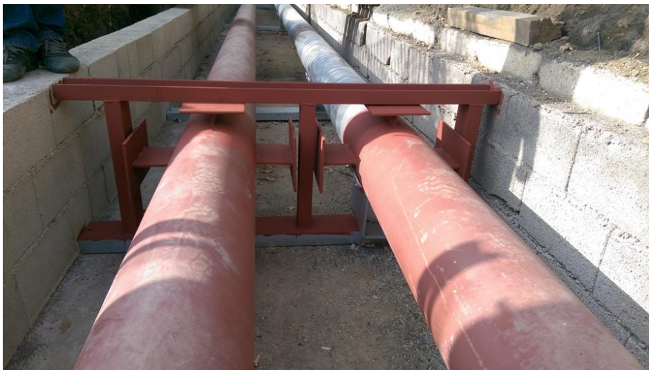
Slika 29: 1. faza obnove podporja vročevoda Šalek - Selo (2015)
