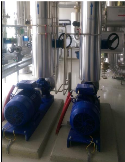
Slika 20: Obtočne črpalke v TPP 505 PA (2014)
