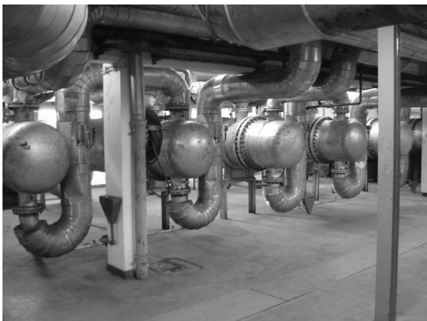
Slika 4: Toplotni prenosniki v CEP (1979)
