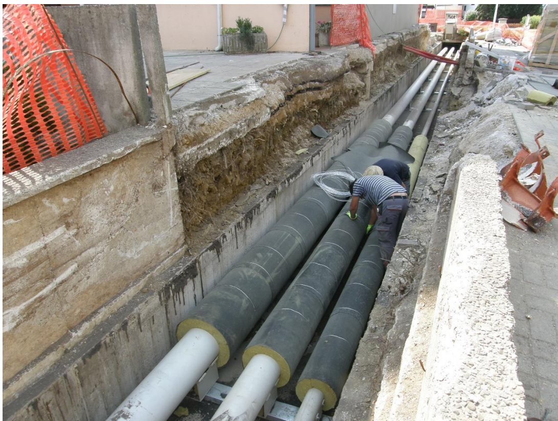
Slika 26: Obnova odseka distribucijskega omrežja CEP 120/70°C – severna veja (2013)
