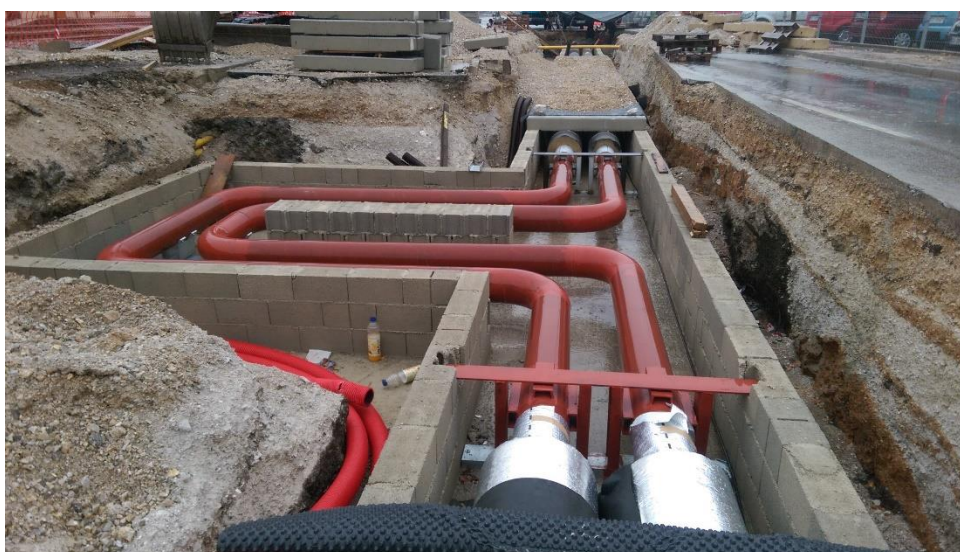
Slika 31: 1. faza gradbenih del na vročevodu Šalek - Selo (2015)
