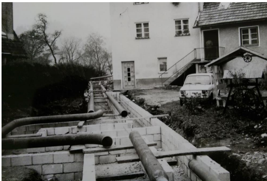
Slika 8: Gradnja distribucijskega omrežja v Šoštanju (1979)
