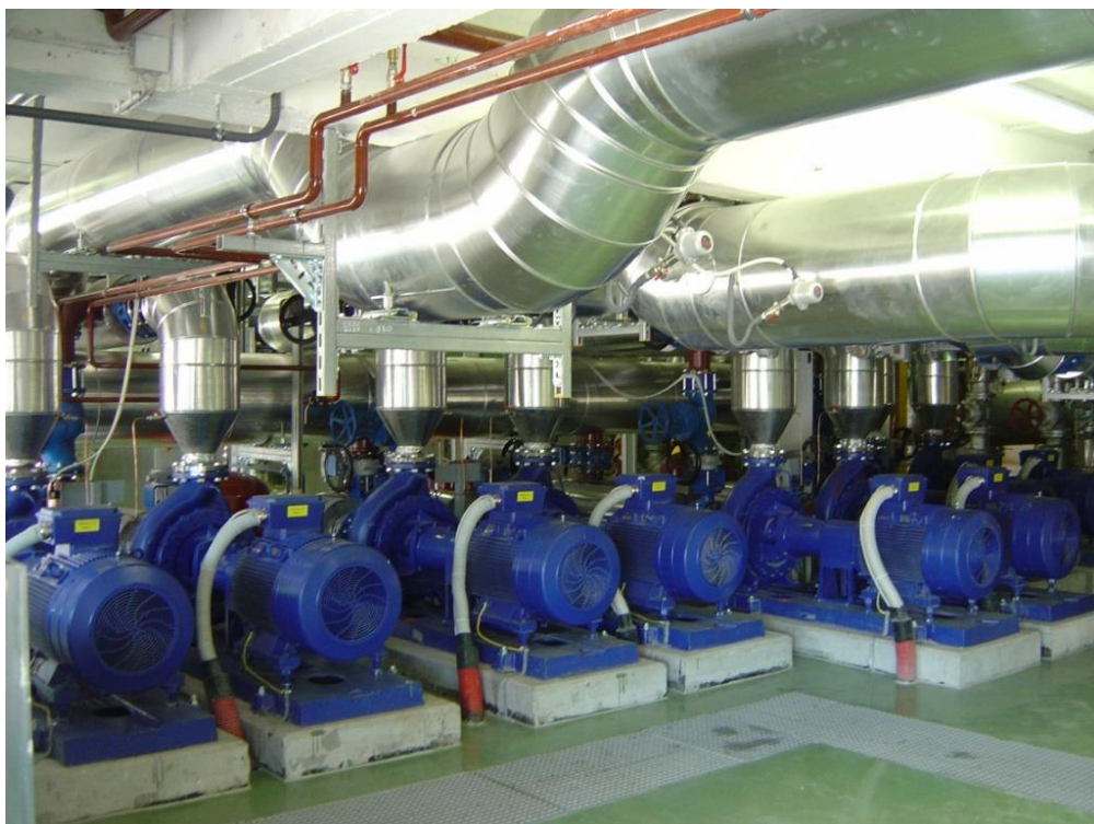
Slika 24: Obtočne črpalke za tri cevno omrežje (2008)
