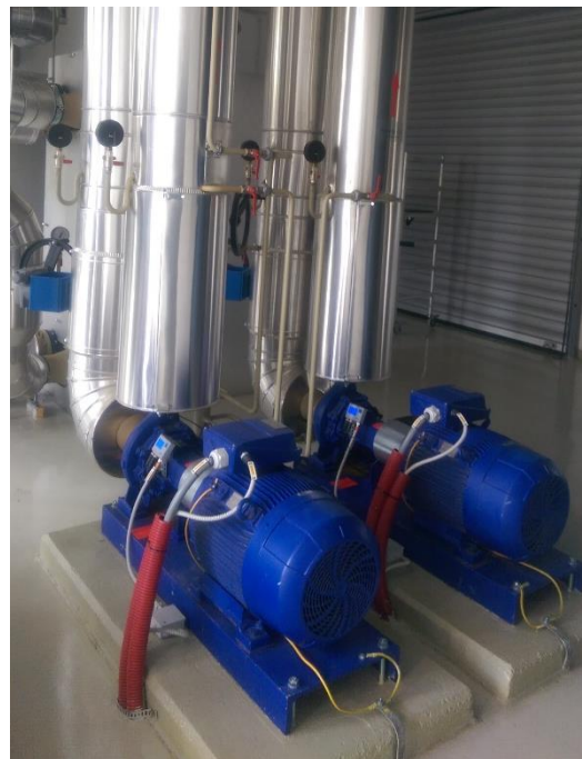
Slika 21: Obtočne črpalke v TPP 505 PB (2014)
