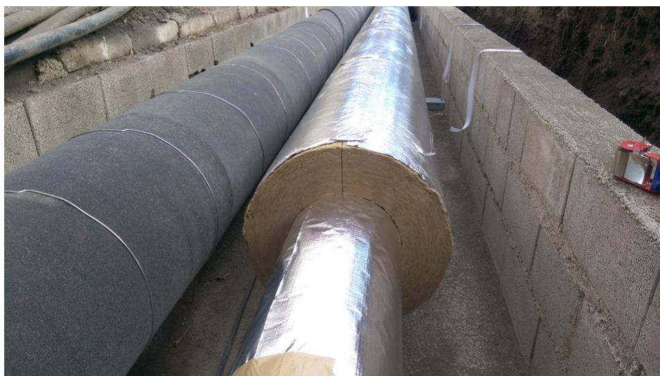
Slika 30: 1. faza obnove izolacije vročevoda Šalek - Selo (2015)
