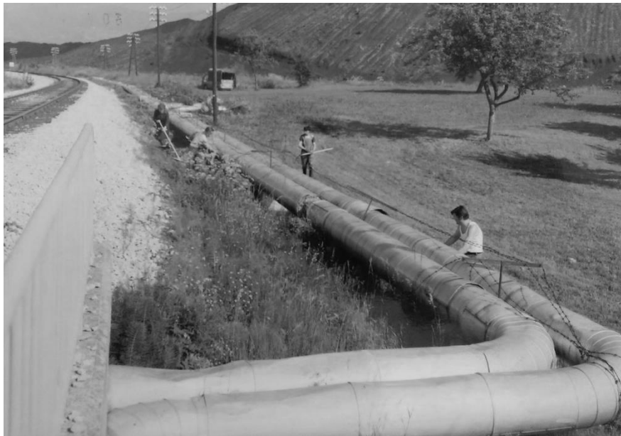
Slika 6: Prvi magistralni cevovod 2x DN 250 (1978)
